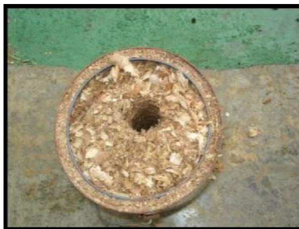
Imagen 4. Detalle de los orificios una vez sacados los cabos de bambú.
